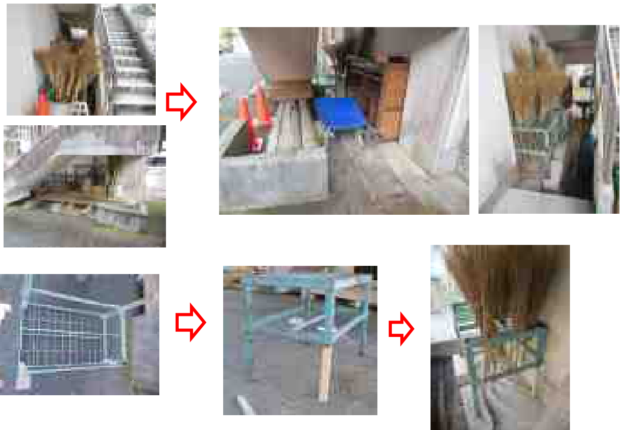
針金で格子を造り、脚を補強して竹箒立てにした。2019.12.24
