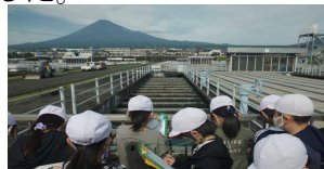
厚原浄水場 沈砂池と富士山
