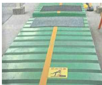
滑り止め施工
